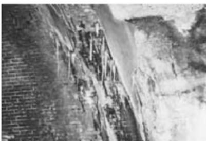
写真12 煉瓦とコンクリートの隙間の氷柱 (2005/1、南東から)
