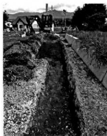
トレンチ3 (南側から)
