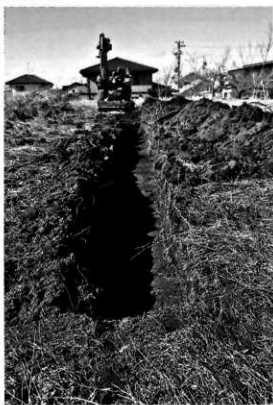
トレンチ2（東側より）
