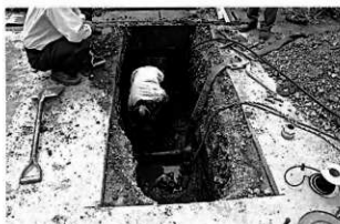
写真10 表町遺跡 (水道管敷設工事)
