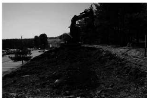
6 A区表土除去中(北から)
