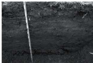
Cトレンチ土層
