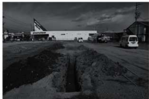
Fトレンチ (南から)
