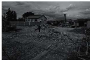
調査地近景 (南西から)
