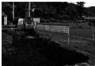
トレンチ掘削状況
