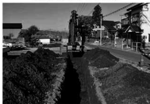
トレンチ掘削状況
