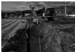
トレンチ掘削状況
