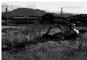
トレンチ掘削状況
