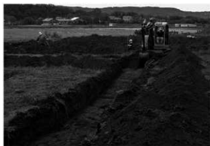
トレンチ掘削状況・作業風景
