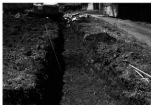
トレンチ掘削状況
