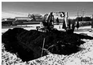
トレンチ掘削状況
