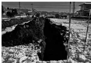
トレンチ掘削状況
