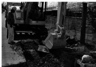
トレンチ掘削状況
