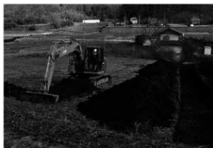
トレンチ掘削状況
