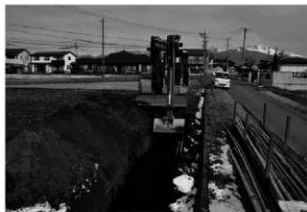
トレンチ掘削状況
