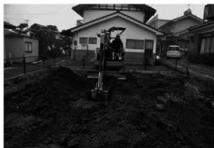
トレンチ掘削状況
