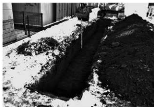
トレンチ掘削状況
