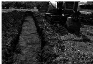
トレンチ掘削状況
