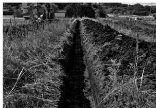
トレンチ掘削状況
