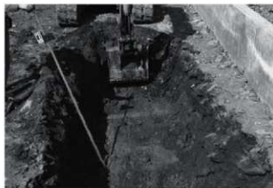
トレンチ掘削状況
