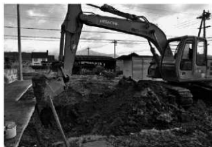
トレンチ掘削状況
