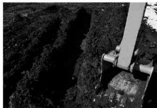
トレンチ掘削状況
