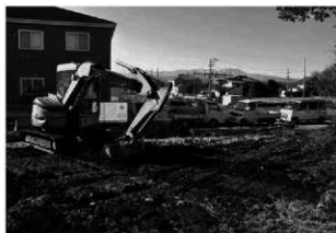
トレンチ掘削状況
