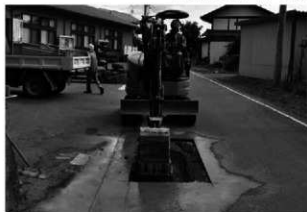
トレンチ掘削状況
