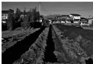
トレンチ掘削状況
