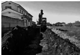
トレンチ掘削状況
