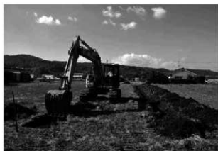
トレンチ掘削状況
