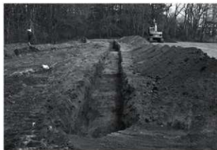
トレンチ掘削状況
