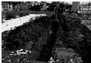
トレンチ掘削状況
