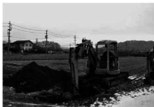
トレンチ掘削状況
