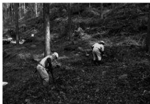
トレンチ掘削状況
