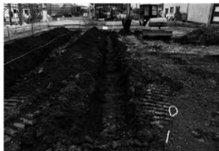
トレンチ掘削状況
