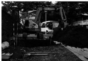
トレンチ掘削状況
