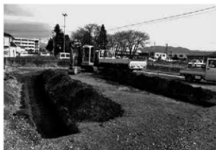
トレンチ掘削状況
