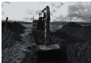
トレンチ掘削状況
