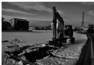
トレンチ掘削状況
