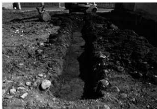
トレンチ掘削状況
