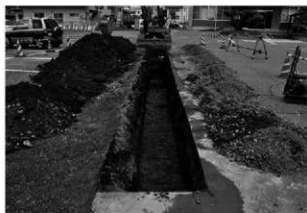
トレンチ掘削状況
