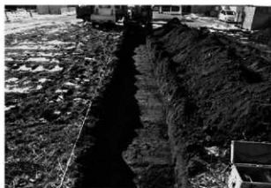
トレンチ掘削状況
