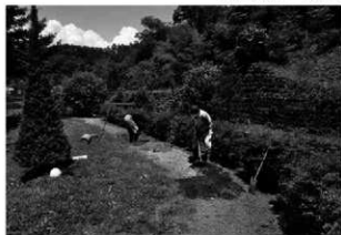
トレンチ掘削状況
