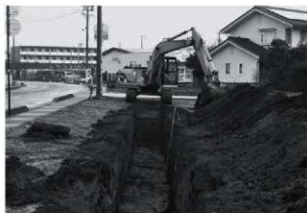
トレンチ掘削状況
