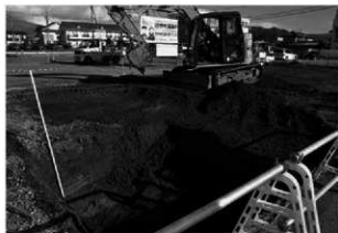
トレンチ掘削状況
