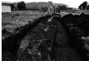
トレンチ掘削状況
