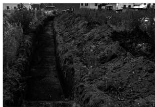
トレンチ掘削状況
