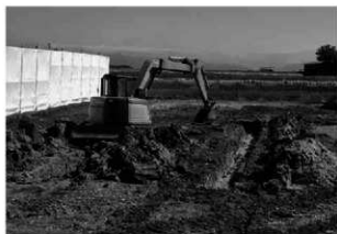
トレンチ掘削状況
