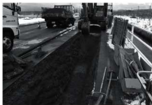
トレンチ掘削状況
