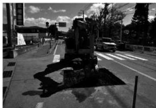
トレンチ掘削状況
