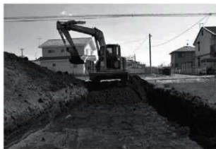
トレンチ掘削状況
