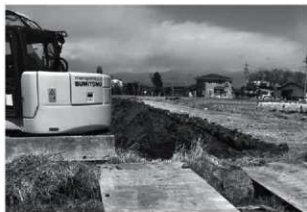
トレンチ掘削状況
