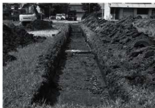
トレンチ掘削状況
