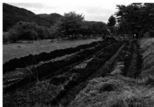
トレンチ掘削状況
