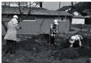
トレンチ掘削状況
