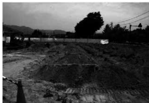
トレンチ掘削状況
