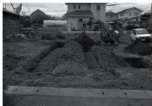
トレンチ掘削状況
