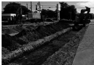
トレンチ掘削状況
