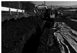
トレンチ掘削状況
