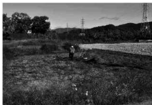
トレンチ掘削状況
