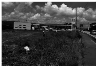
トレンチ掘削状況
