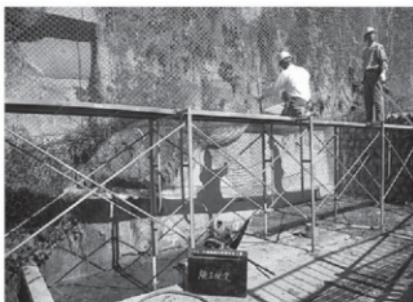
写35 平成24年度保全工事 落石防護ネット設置
