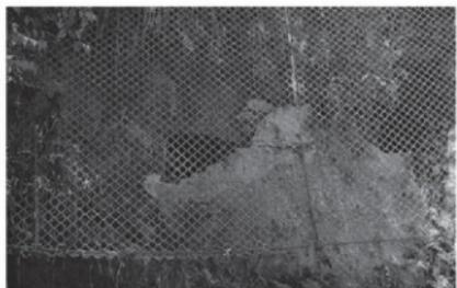
写5 岸壁に発見された空洞開口部
