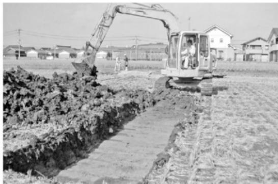
写真2 トレンチ掘削状況
