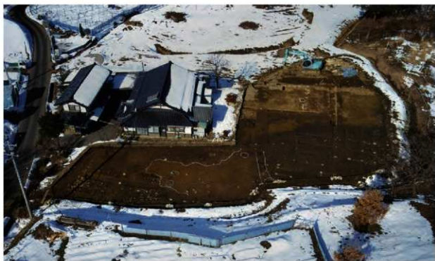
E区全景(南東方向の上空から撮影)
