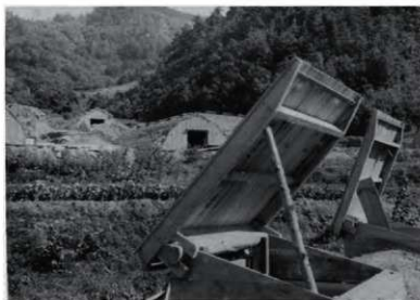
写真2 半地下工場の窓
