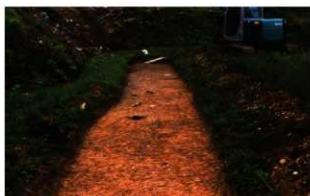
C区東Tで確認された硬化面
