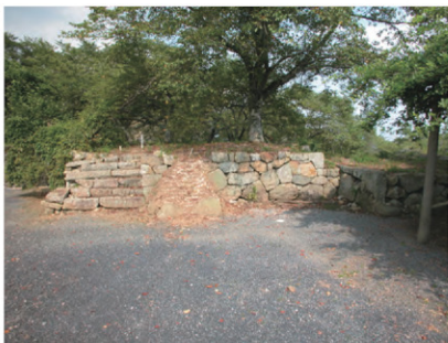
1. 調査区1 調査前 (西から)
