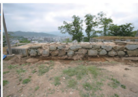
多門櫓腰石垣修理前 (南から)
