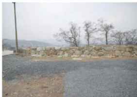
石垣解体修理完了 (多門櫓腰石垣南面)
