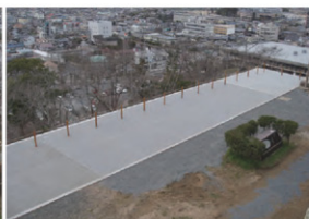
整備工事完了 (南東から)
