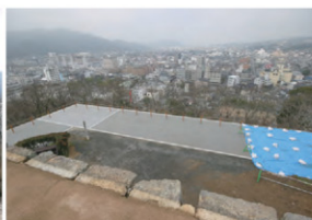
舗装後（北東から）
