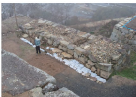
整備工事着手前 (南東から)
