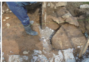
裏込補強作業
