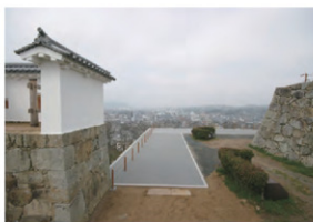
舗装後（東から）
