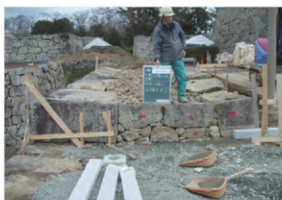
石積み直し (七番門南石垣西面)
