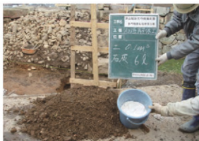
裏込補強状況
