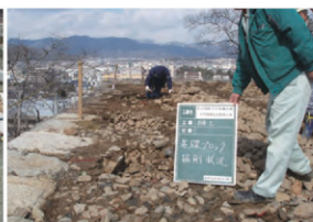
転落防止柵基礎ブロック掘削
