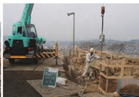
石垣解体作業
