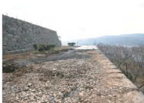
舗装後（北から）
