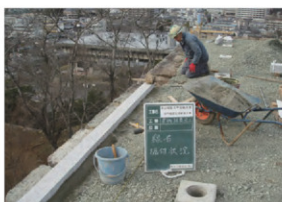
緑石据え付け
