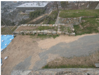
1. 調査前全景 (南から)
