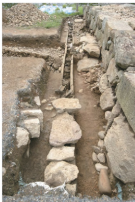
写真3 多門櫓腰石垣南の排水溝（東から）
