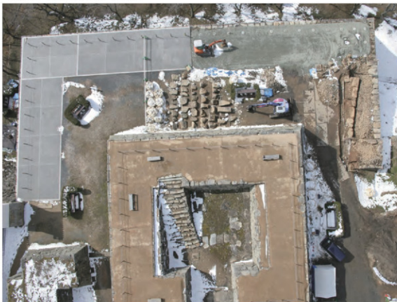
埋没石垣発見時航空写真 (写真右端)
