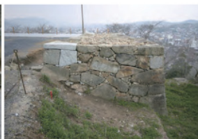
石垣解体修理完了 (七番門南石垣東面)
