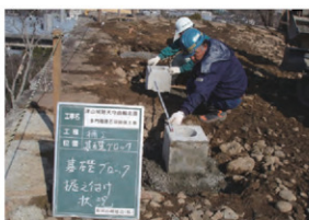
転落防止柵基礎ブロック据え付け
