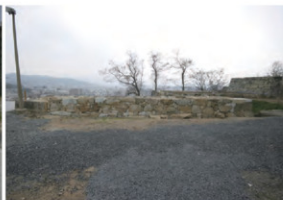
石垣解体修理完了 (全体)
