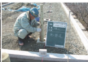
転落防止柵据え付け
