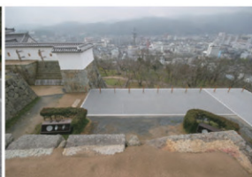
舗装後（北から）
