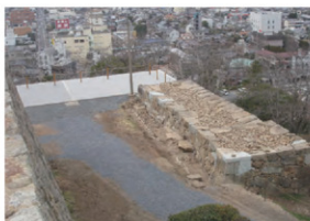
整備工事完了 (東から)
