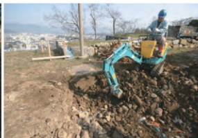
ハンドホール移設作業
