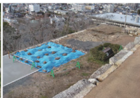
整備工事着手前 (南東から)
