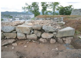
七番門南石垣南面修理前 (南から)
