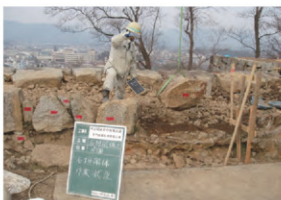
石垣解体作業
