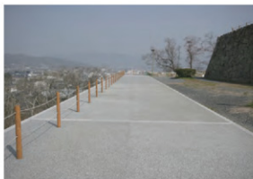
整備工事完了 (南から)
