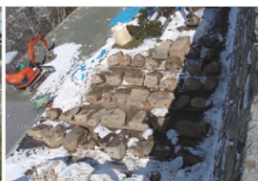
解体した石の仮置き
