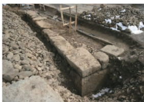
埋没石垣 (北面と西面)
