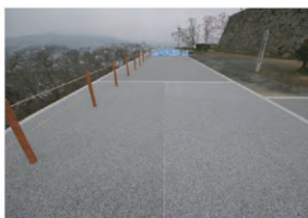
舗装後（南から）
