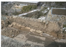
解体中に発見された埋没石垣
