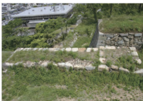
整備前 (南から)
