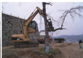
樹木伐採作業
