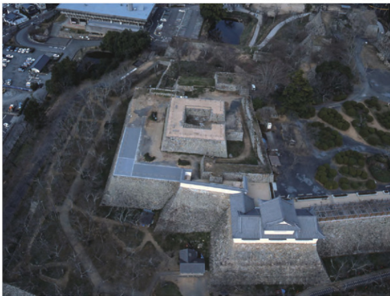
整備工事後航空写真（上が北）
