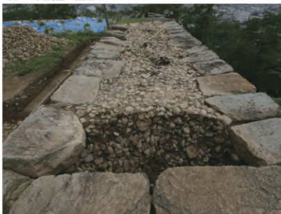
1. 調査区2多門櫓腰石垣栗石 検出状況(東から)
