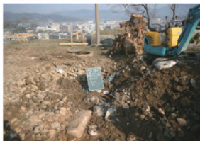
ハンドホール移設作業
