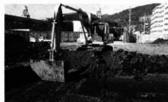
重機による表土剥ぎ
