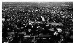
調査地遠景（中央の高い建物が1号棟）
