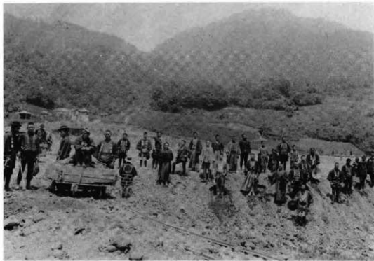
長野高女造成工事（明治34年）
