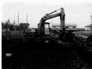
重機表工剥ぎ
