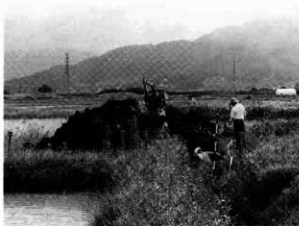
試掘坑掘削状況
