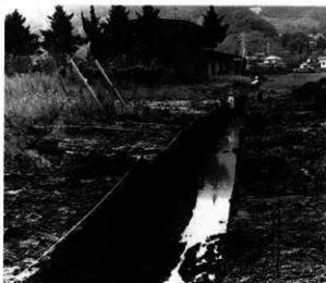
13号トレンチ掘削状況
