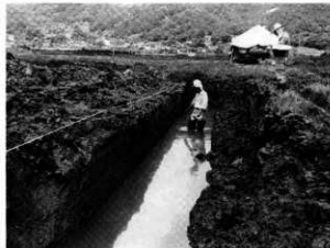
試掘坑掘削状況
