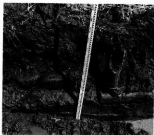
暗渠断面と立ち上がり (土管)
