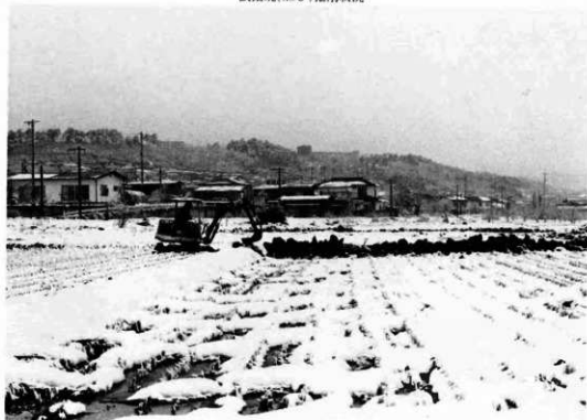
試掘坑(No.4)掘削状況
