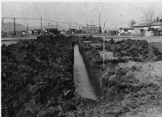
第9号トレンチ
