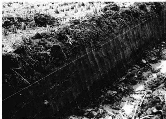
試掘坑(No. 1)土層断面
