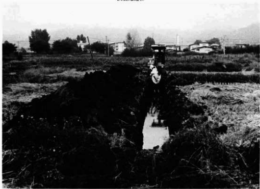
試掘坑(No.2)掘削状況
