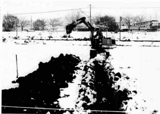
試掘坑(No.5)掘削状況
