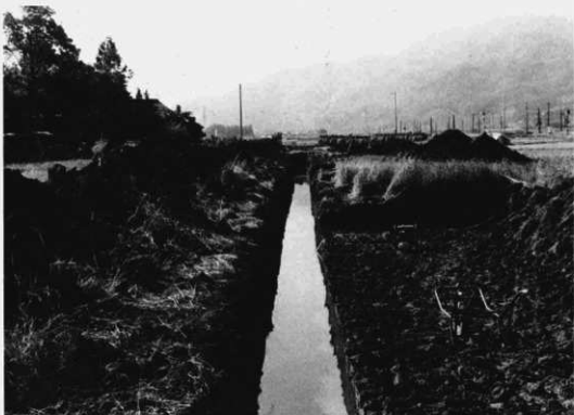
第10号トレンチ
