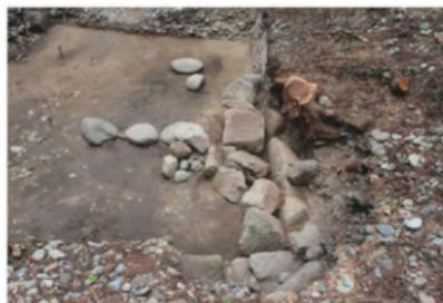
▲石垣DD'列石垣崩落状況(東から)
