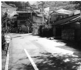
A地区調査地遠景
