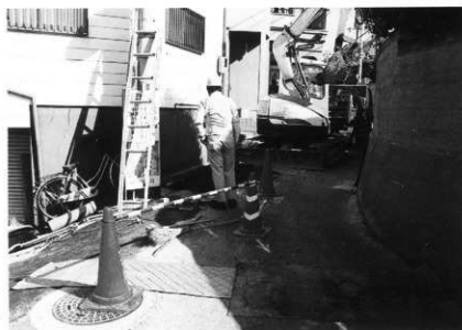
C地区調査状況
