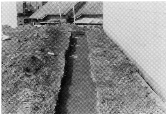
TRK 89-5 トレンチNo. 4 ビット検出状況
