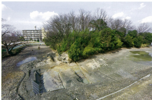
調査区全景(南西から)
