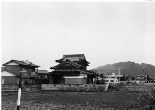
▲調査前（西から）
