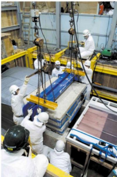
天井石3の取り上げには、II型治具が使用され、バランス調整のため、5基のチェーンブロックを操作して地切りをおこないました。
