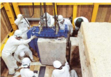
東壁石3（女子群像）は、床石と壁石の間と上部の相欠き部の隙間に先端刃を挿入してI型治具を取り付けて、地切りと移動をおこなった。
