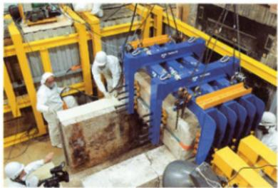
最も危険な天井石1（南側）は、II型治具と補助治具を用いて、四方から石材を拘束して、地切り・移動した。
