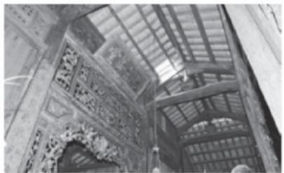
図35 先祖壇廻り彫刻と棟束形式の架構
