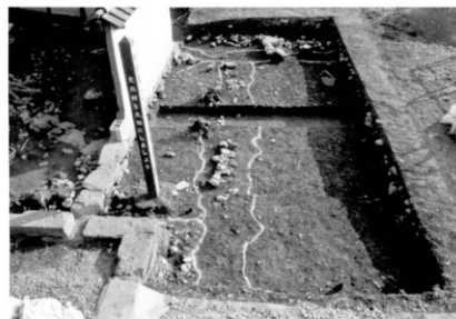
第4トレンチ調査区 (北より)
