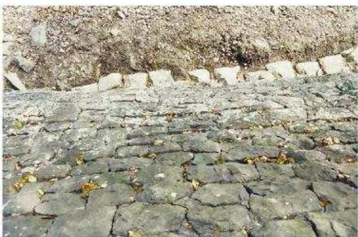
石垣下端変形①と上部積み直し部 (E面: 東端, 南上から)
