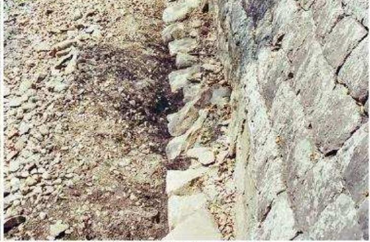
Eトレンチ東端 石垣下端の変形 (E面: 南西から)
