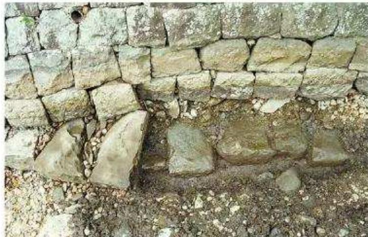
石垣下端の変形と土管埋設 (E面: 西から)
