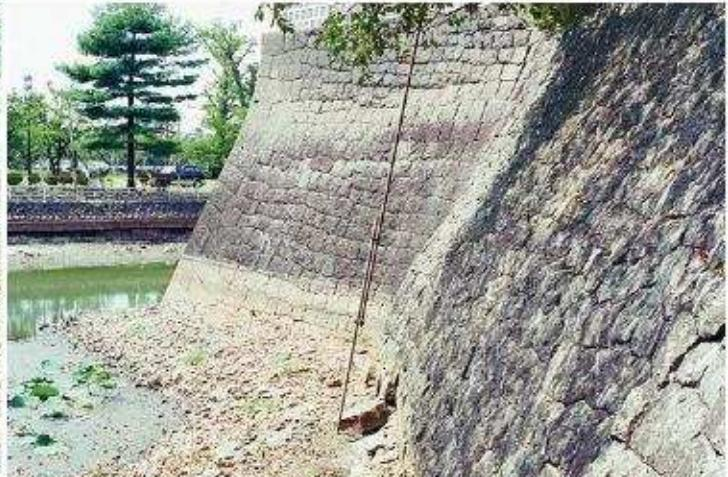
石垣下端の変形と土管埋設 (E面: 西から)
