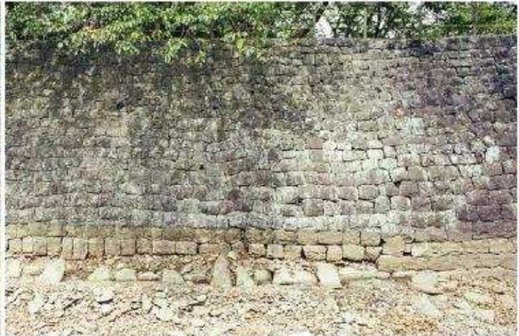
石垣下端の変形と上部積み直し状況 (正面: 西側)
