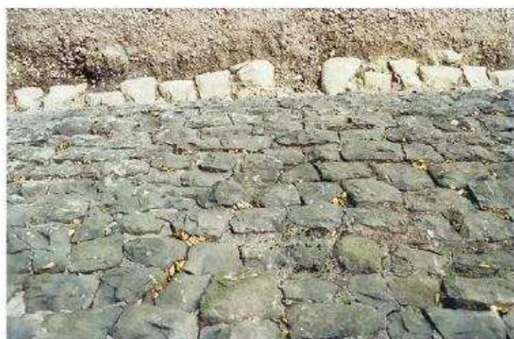
石垣下端変形①と上部積み直し部 (E面: 中央, 南上から)
