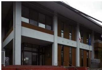
写真 58 改修後外観・北西から
