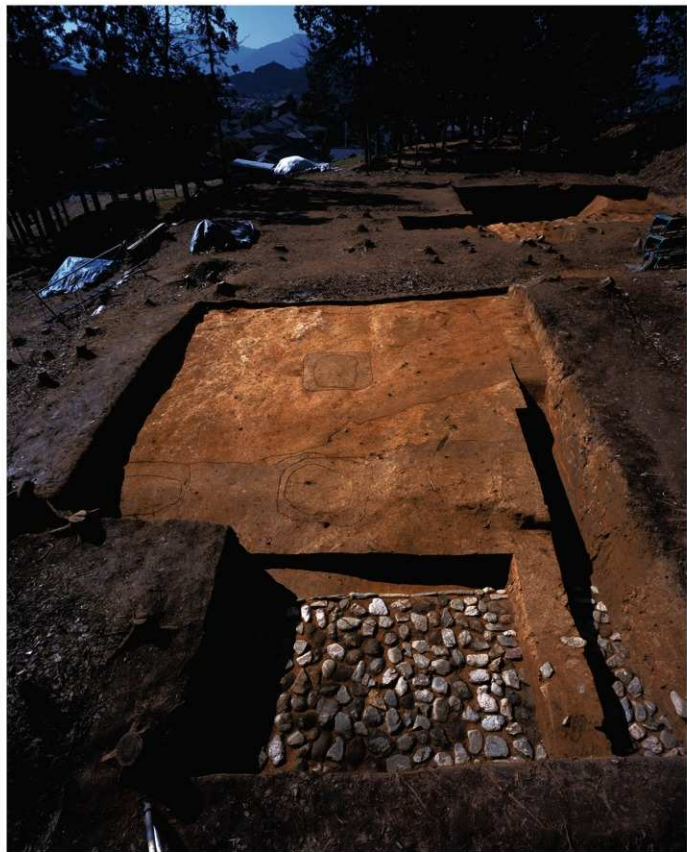
写真31 9トレンチ 完掘状況 -東から-
