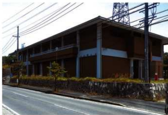
写真 57 改修後外観・南西から
