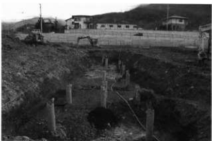
18号トレンチ (西より)
