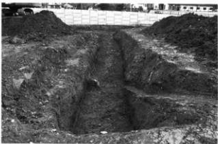
20号トレンチ (西より)
