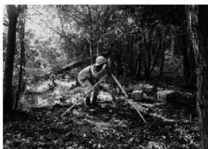
測量基準点の設置作業
