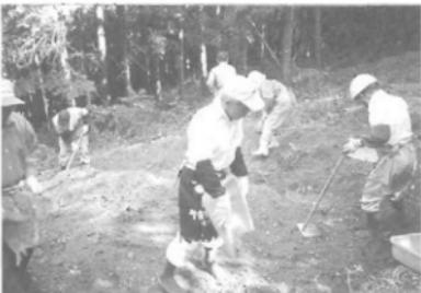
写真4 試掘溝の埋め戻し作業状況
