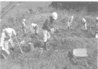
写真5 表土除去作業状況
