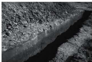
1. 試掘トレンチNo.22(西から)
