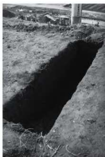
5. 試掘トレンチNo.33-b(北から)
