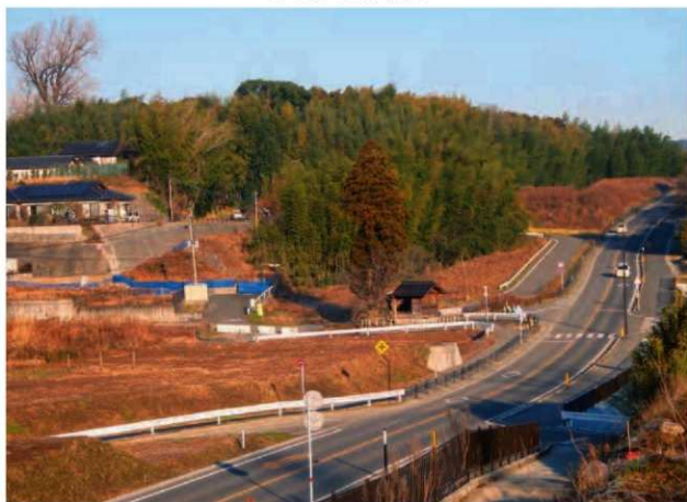
12 榑木バイパス（南から）
