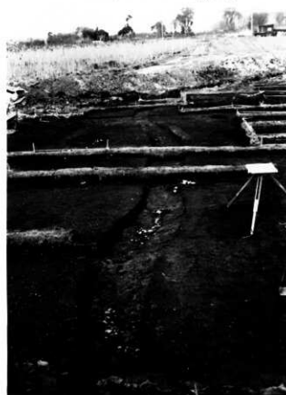
M1全景 (南より)
