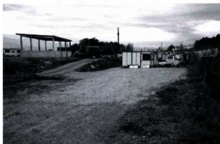
ハウス等設置・駐車場整地等状況（北東から）
