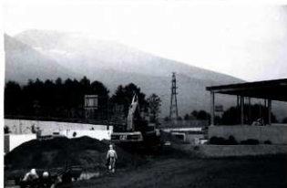
調査風景・表土除去作業（南西から）
