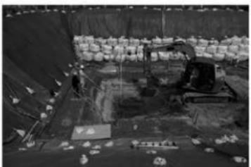
写真9 表土重機掘削作業
