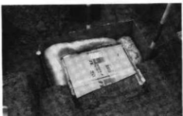
写真-4 発泡硬質ウレタン樹脂の充填
