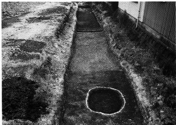
(1) T-2 全景 (北より)
