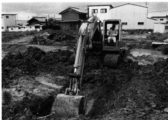
(2) T-2 表土除去（北より）
