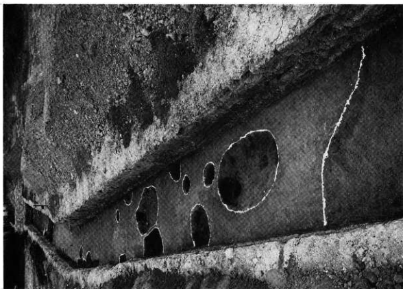
(2) T-4 全景 (南より)
