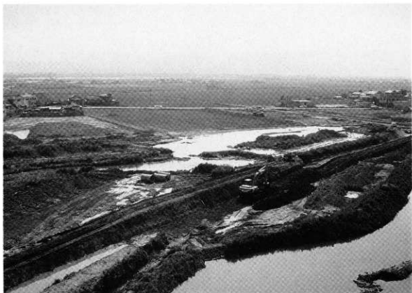
(1) 調査地遠景（東より）
