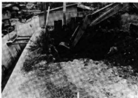
7. 撃壁裏の剥落防止として鋼矢板を打ち、
