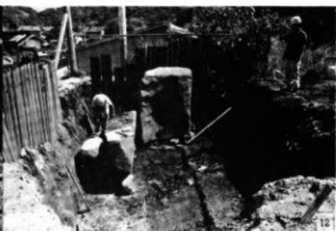
12. 左同 組め石で高さと傾斜を調節する
