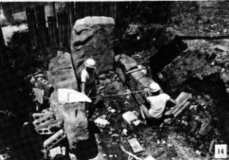
14. 右側根石の据え付け。寸法を点検しながら
