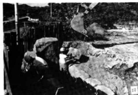
17. 右側2段目石積み・吊り下げ作業
