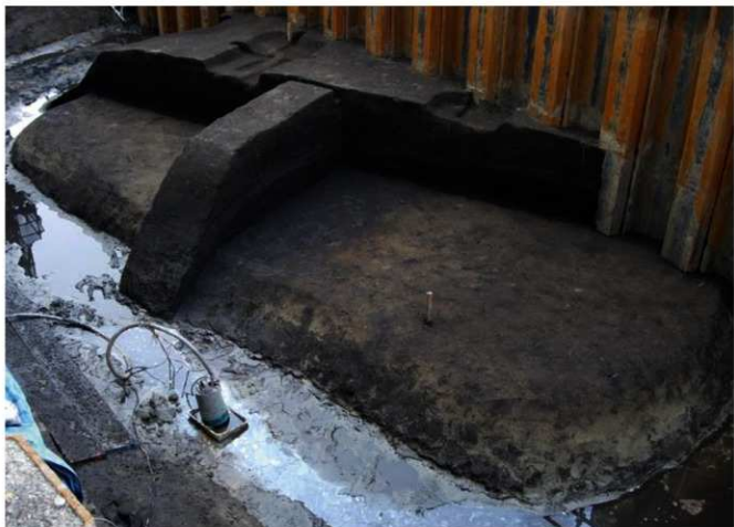
● 05Dd 区 - SZ168 盛土調査風景
