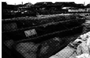
発掘区南西部西壁 (南東から)
