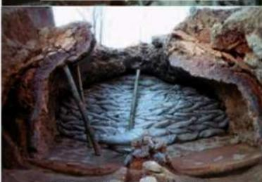
001SY 焼成室下半の断面構造
