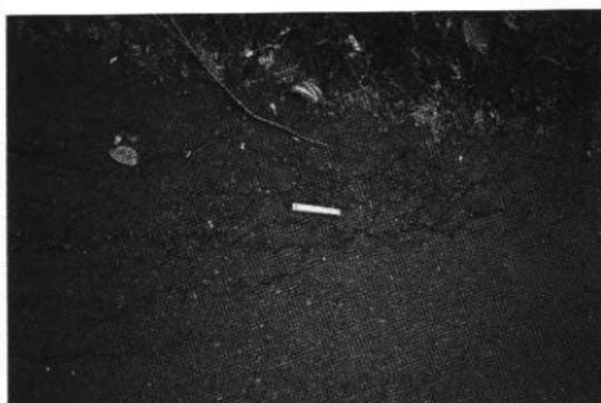
第51図 アスファルト路面上に生まれた展張亀裂(スケールの長さは20cm)
