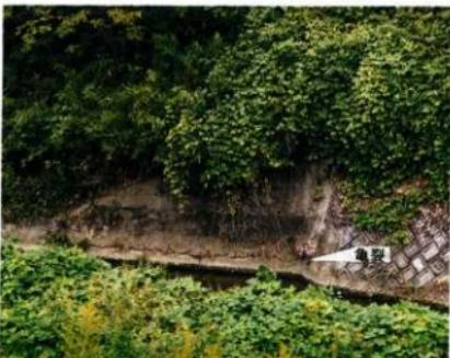
写真89 護岸擁壁の亀裂
