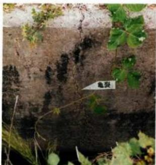
写真90 水路側壁の亀裂
