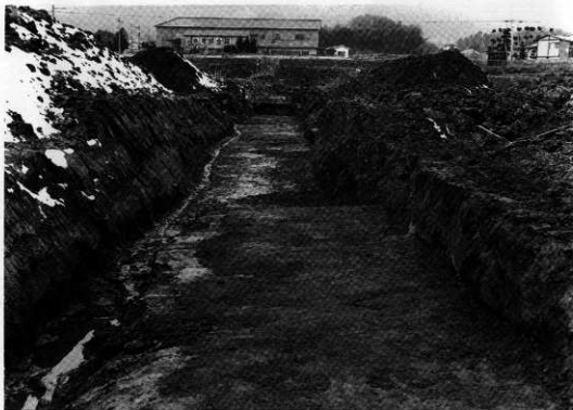
第3トレンチ (東から)
