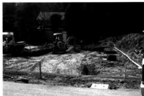
写真4 正徳寺遺跡試掘調査
