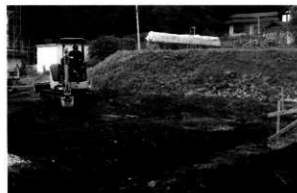
写真3 正徳寺遺跡工事立会
