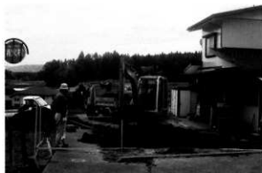
写真22 宮ノ越遺跡工事立会
