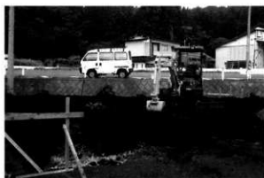
写真4 川久保遺跡（倉庫建設）
