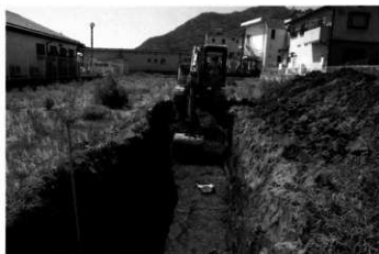
トレンチ掘削状況 (北より)
