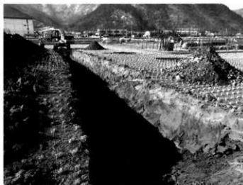
1号トレンチ検出状況 (東より)
