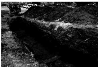
トレンチ掘削状況 (東より)
