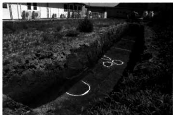
トレンチ検出状況 (北より)
