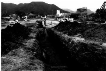
トレンチ検出状況 (東より)
