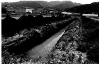
2号トレンチ検出状況 (西より)
