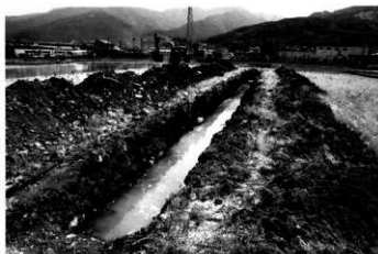
1号トレンチ検出状況 (西より)
