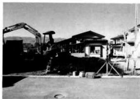
図版 87 調査区全景
