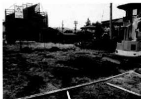
図版45 調査区全景
