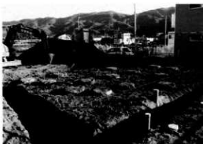
図版61 調査区全景
