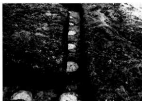
図版 86 掘削状況 2
