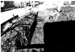
図版70 基礎西辺(南東から)
