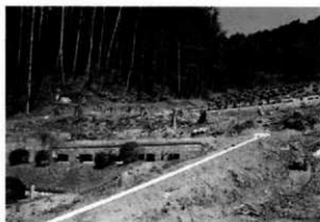
図版 18 調査前全景 1
