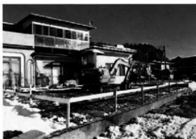
図版80 調査区全景
