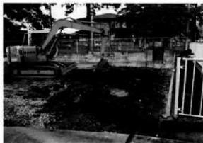
図版 67 調査区全景
