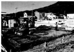
図版65 調査区全景
