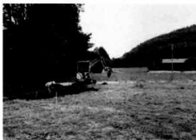
図版 30 調査区全景
