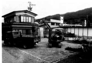
24-6 上原城下町遺跡 (1) 調査区現況 (南から)
