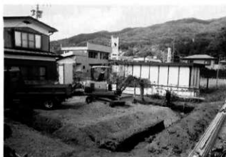
(3) 調査区全景 (南から)
