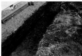
(5) 擁壁基礎② (東から)
