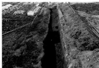
05 調査区(擁壁)近景 (南東から)
