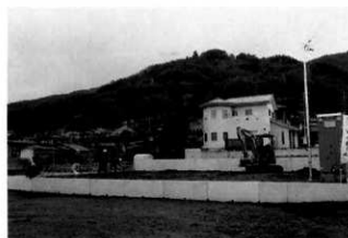
24-10 上原城下町遺跡 (1) 調査区現況 (南西から)
