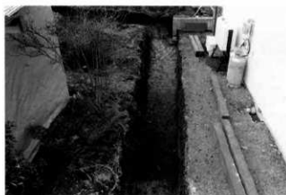
(4) 擁壁基礎① (西から)
