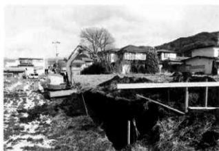
24-8 上原城下町遺跡 (1) 調査区(擁壁)現況 (南から)
