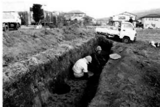
06 調査状況 (北西から)
