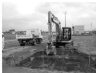
写真3 A地区表土掘削
