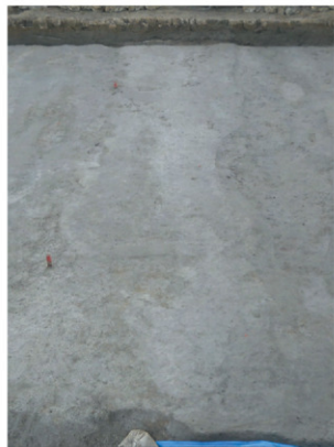
SM1 (B地区1面東西方向の大畦畔)
