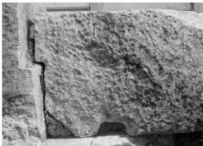
図147 天井石合欠きの組み合わせ（漆喰除去後の天井石3・4東側面）
