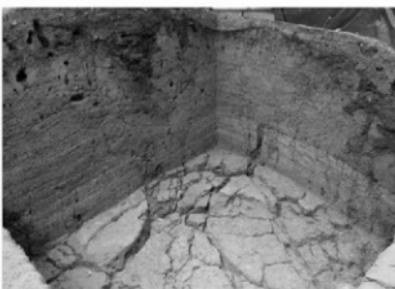
図141 版築層の断面と縦横に走る地震痕跡
